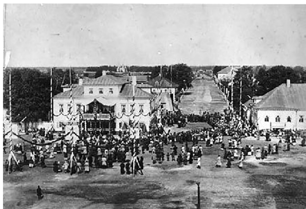
Рис. 1 Вид с Соборной колокольни на дом купца А. А. Крехалева (слева) и Санкт-Петербургскую улицу. Фото. 1892 год
