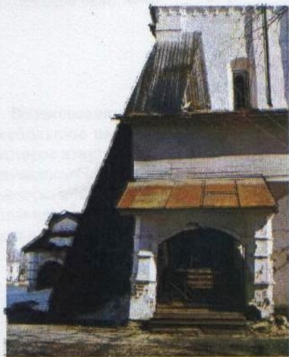
Северо-западный угол Христорождественского собора с крыльцом паперти и контрфорсом.
